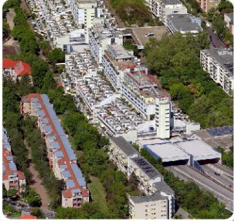
독일, 슐랑겐바더 슈트라세 (도로상부 개발)
